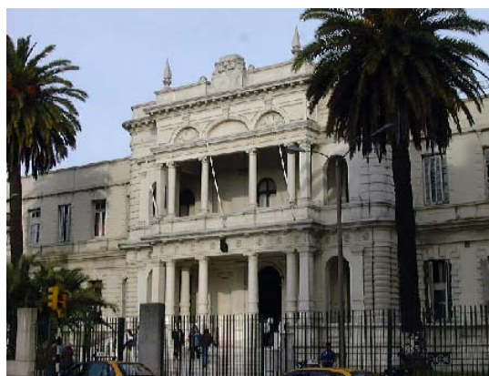
Figura 3 Fachada actual del H.C.FF.AA. (puerta de entrada por Avda. 8 de Octubre).
